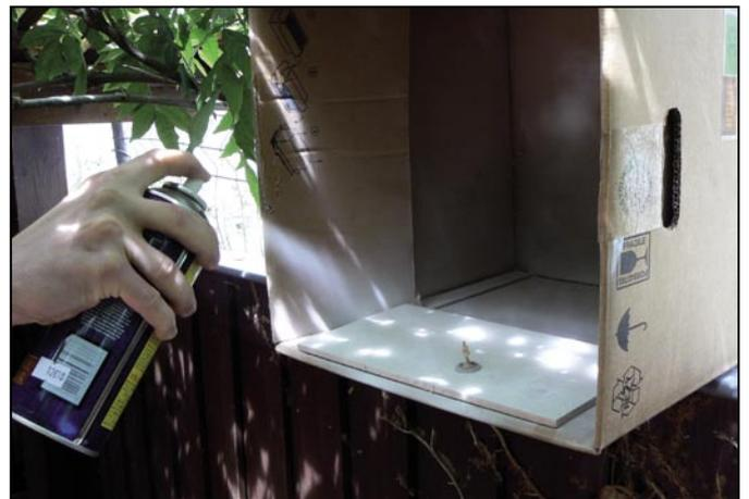
La sous-souche doit être homogène et bien fine. Le léger effet granuleux de la sous-couche est normal. C'est ce grain qui va permettre à la peinture d'accrocher.
